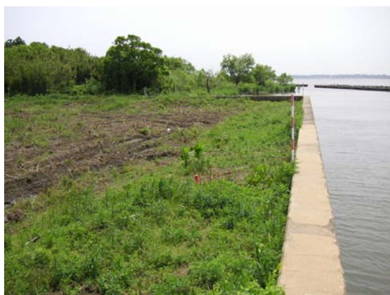
陸と湖面がコンクリート護岸により分断
