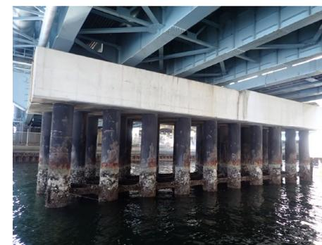
腐食したパイルベント橋脚(鋼管杭)に被覆防食等の補修を実施
