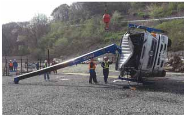
引き上げられたクレーン
