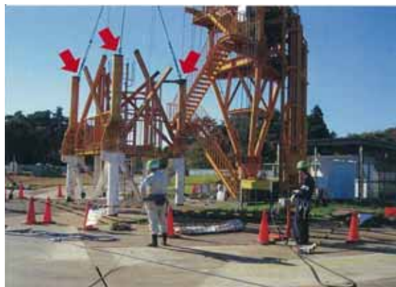
解体作業の状況
