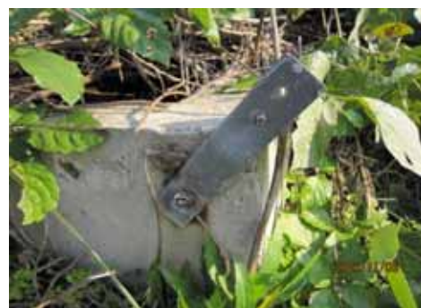
コンクリート片
