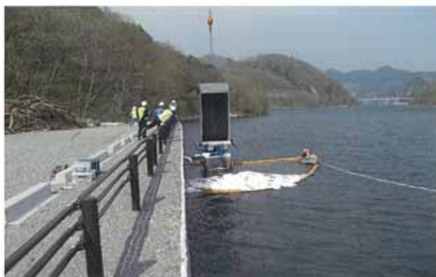
クレーンの引き上げ作業状況
