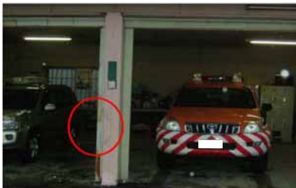
(接触事故発生場所)
