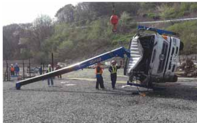
引き上げられたクレーン
