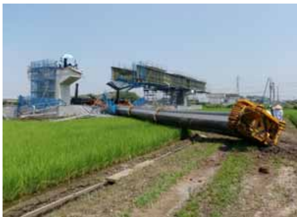
クレーン転倒状況
