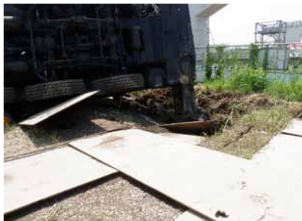
アウトリガー陥没状況
