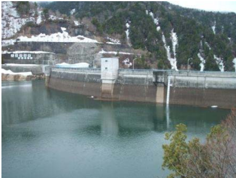
満水に向け約70%貯留した矢木沢ダム状況（平成20年4月18日撮影）
