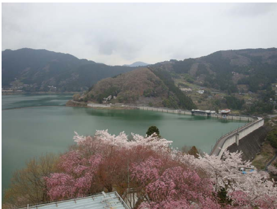
下久保ダム(平成22年4月15日撮影)
