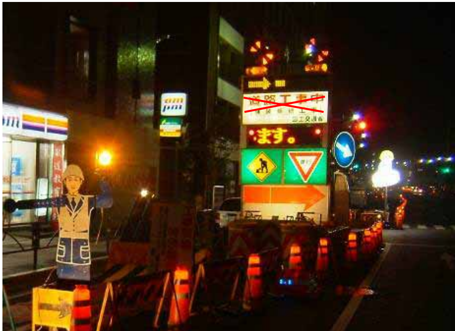
工事中（内部照明型）標示板の工事種別の表示が「舗装工事中」ではなく、「道路工事中」と標示されている。
