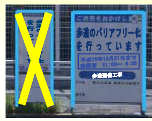
工事説明看板がドライバーに対し設置されている。
