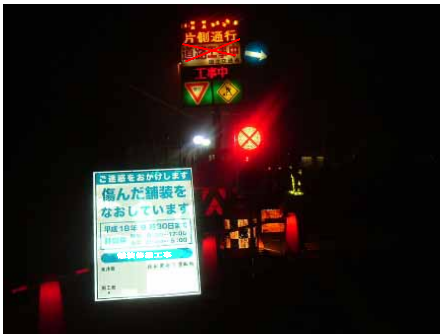
工事中（内部照明型）標示板の工事種別の表示が「舗装工事中」ではなく、「道路工事中」と表示されている。
