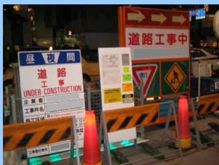
占用工事(地下鉄工事)なのに「道路工事中」と表示している。
