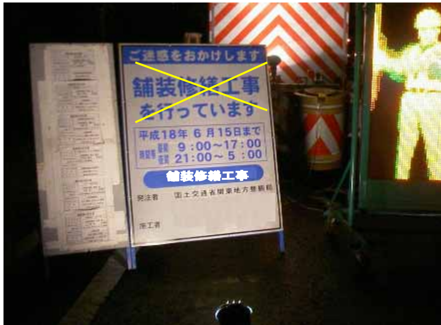
工事中看板の工事目的が、具体的でなく判りにくい。
