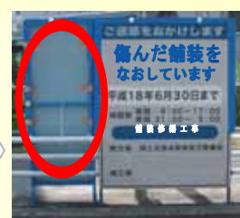
工事説明看板が歩行者に対し設置されている。
