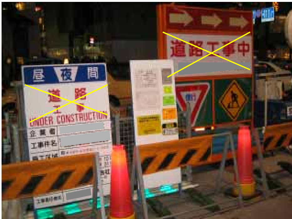
工事種別の表示が「占用工事（地下鉄工事）」なのに「道路工事」と表示している。
