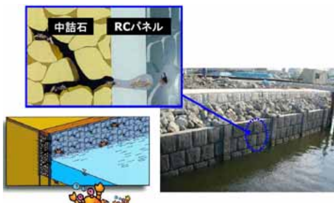
【環境配慮型護岸(東京港かに護岸)】
