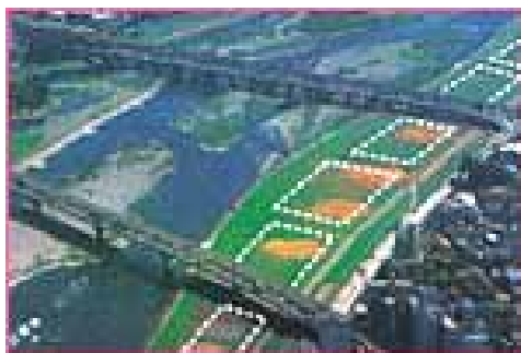
【平瀬川浄化施設（川崎市高津区）】
