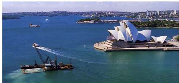
施工写真(沈埋函敷設状況)
