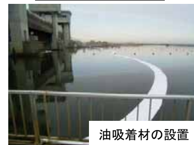
水質事故の状況
