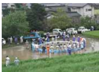
平成13年9月台風15号 埼玉県加須市大越地先漏水被害
