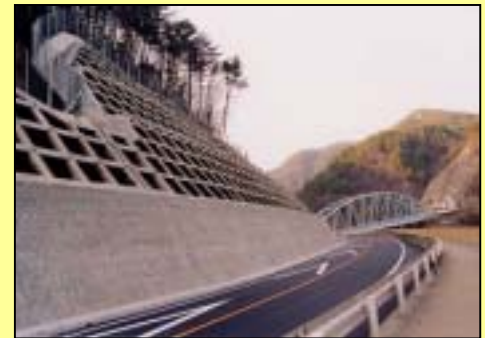
【写真：東広津防災工事】 資料：国土交通省
