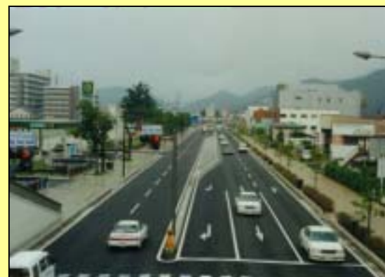
【写真：(一)三才大豆島中御所線 若里 電線共同溝】 資料：長野県
