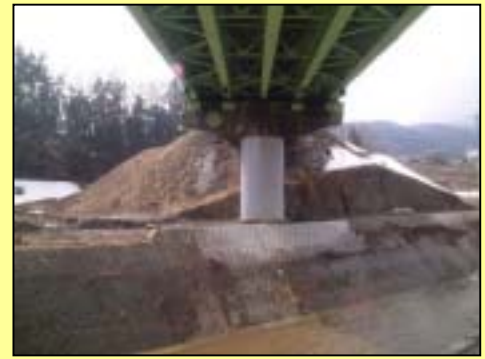
【写真：耐震補強工事】 資料：国土交通省
