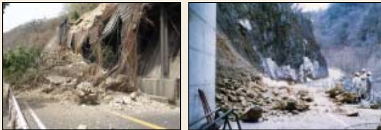
【写真：19号山口地区土砂崩落状況（H13・4）】 【写真：一般県道白骨温泉線 安曇村白骨】
