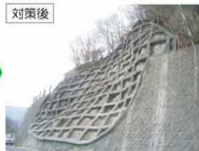
コンクリート吹付け法砕工、鉄筋挿入工
