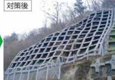
コンクリート吹付け法砕工、鉄筋挿入工
