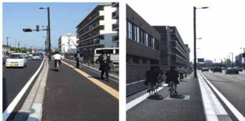
電柱のない美しい市街地を形成
