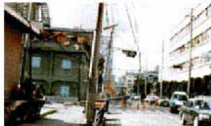
図11-3 阪神大震災で倒壊した電柱
