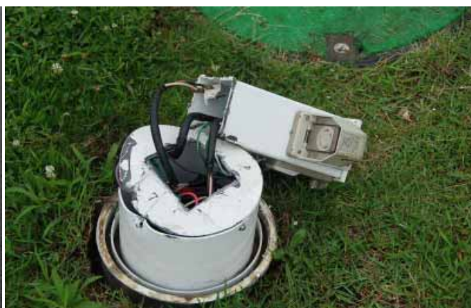
照明損傷状況
