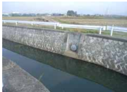
河川流入状況 (バキュームにて吸入後)
