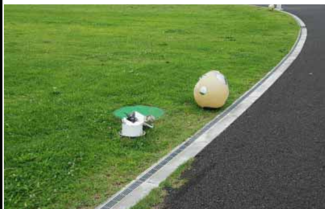
照明損傷状況
