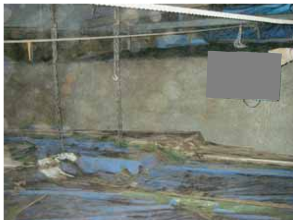
足場内部状況
