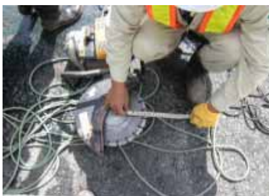
路面補修に用いたハンドカッター
