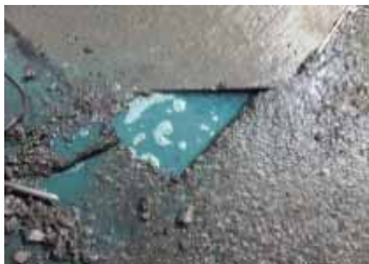
損傷直後写真
