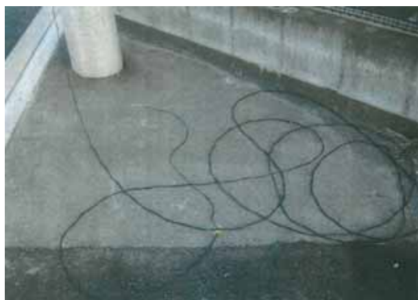
切断したケーブル
