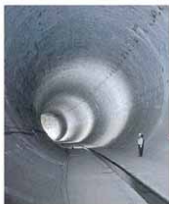
▲神田川・環状七号線 地下調節池
