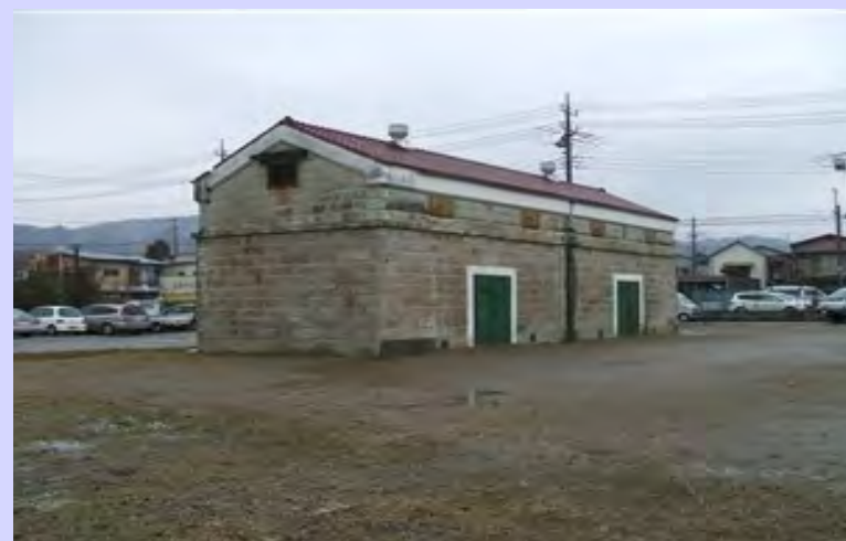
↑ 観光交流センターとして改修予定の既存倉庫
