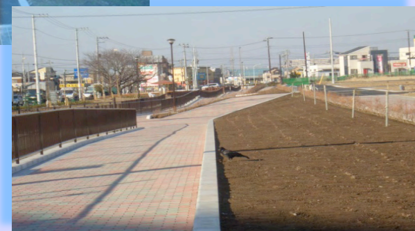
↑ 水路断面の改修済みの箇所を緑道として整備
