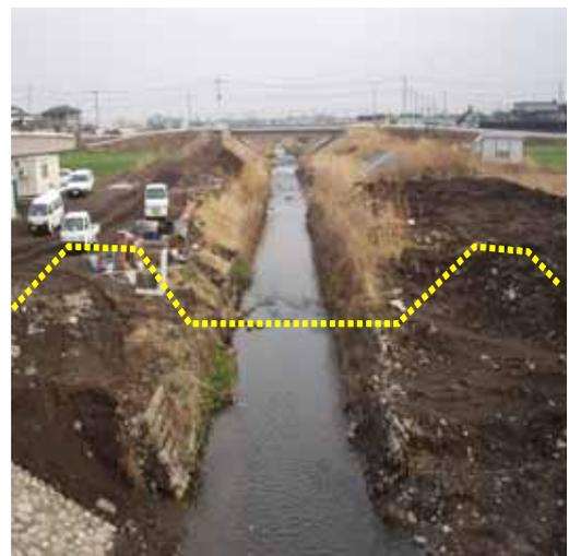
計画流量140m<sup>3</sup>/sに対し、約1割～4割程度しか流下能力がなく、出水の度に氾濫被害が生じている。
