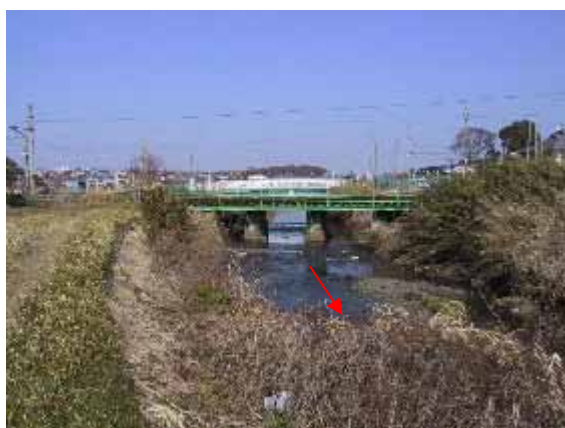
JR相模線小出川橋梁下流より
