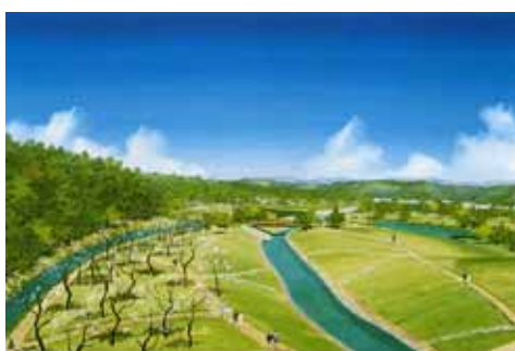
緩勾配堤防による公園と河川の一体化
