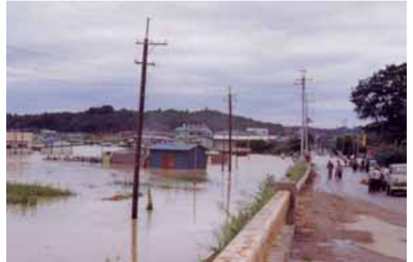
昭和40年代の浸水被害の様子
