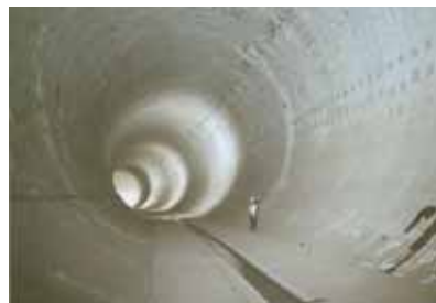
《調節池の内部》
