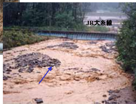
土石流発生状況 (平成11年10月発生)
