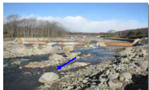
整備状況 床固工群（15年度完成）
