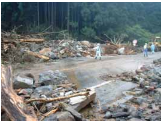
箱根新道(国道1号) 流出状況
