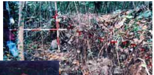
地すべり状況 (平成16年4月)
