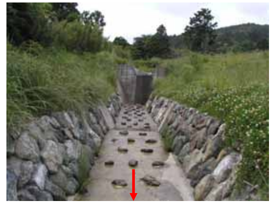
現場の発生材(巨石)を流路工に利用
