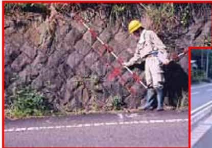
↑①県道沿いのブロック積工に発生した亀裂
