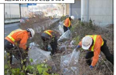
道路清掃実施状況
