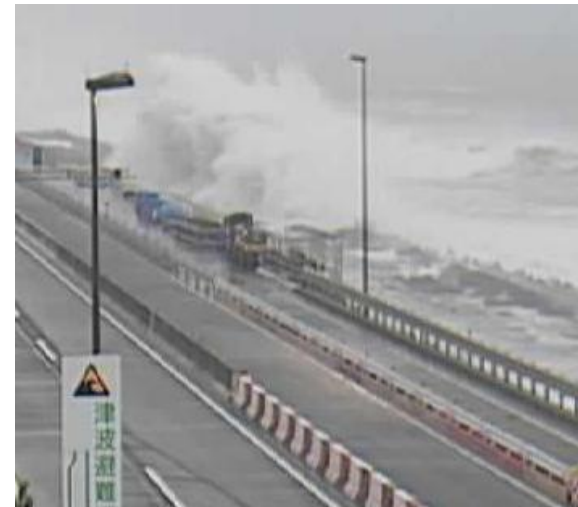
令和元年9月 神奈川県大磯町 国道1号
