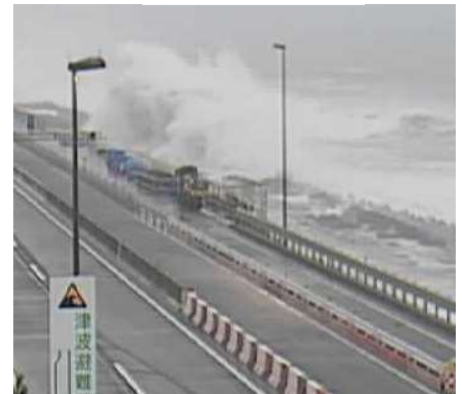
令和元年9月 神奈川県大磯町 国道1号
