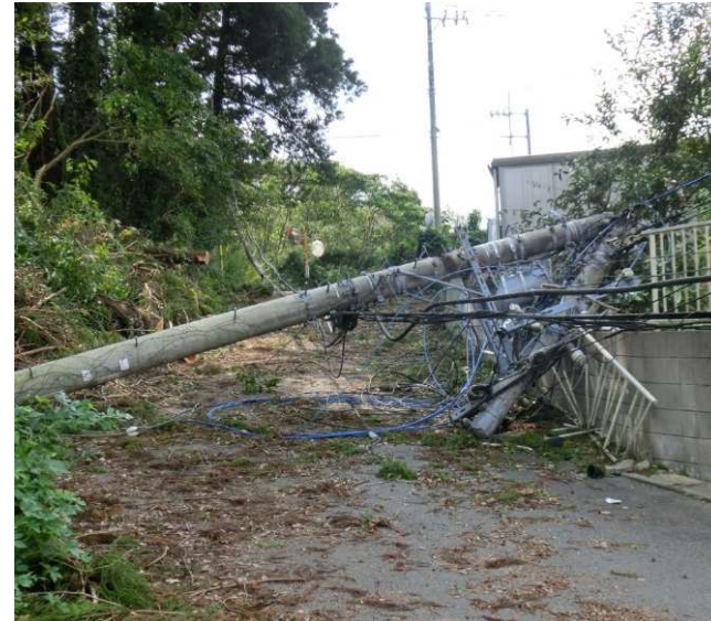
令和元年9月 千葉県山武市 山武市道
