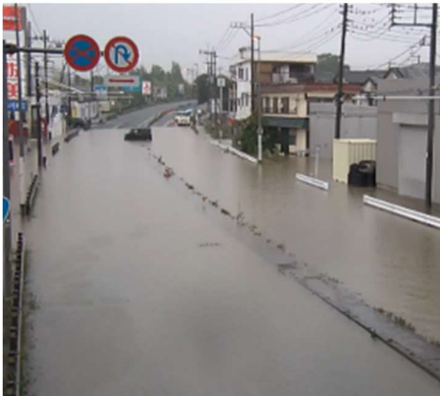
令和5年6月 埼玉県越谷市 国道4号
