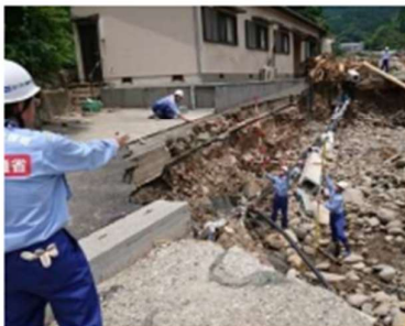
河川被害状況の調査
