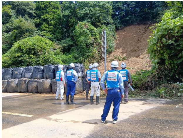
茂原市 活動状況 TEC-FORCEパートナー 被災状況調査(中央開発 株式会社 ・ 株式会社 建設技術研究所)
