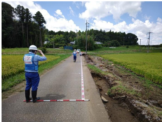
千葉市若葉区 活動状況 被災状況調査
