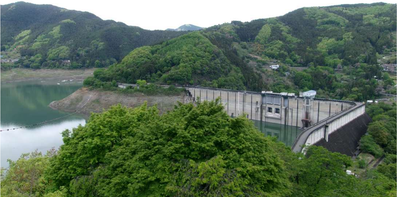
下久保ダム の 貯水 状況 （ 令和 8 年 4 月 27 日 撮影 ）
