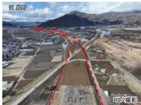
さかきまち あみかけ 坂城町網掛地区の工事状況
