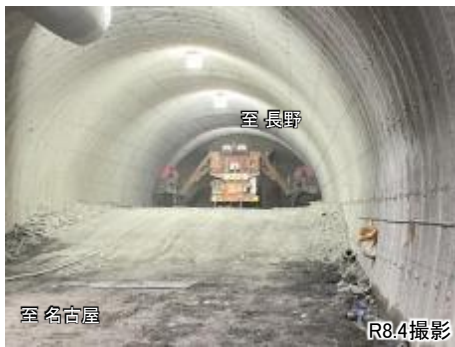
山清路2号トンネルの工事状況
