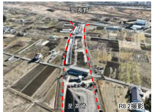
長野市塩崎地区の工事状況
