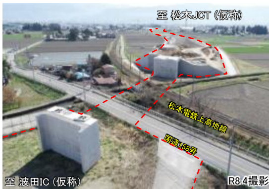
まつもと いむら 松本市新村地区の工事状況
