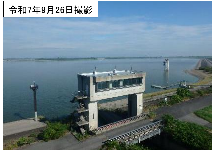
渡良瀬貯水池
