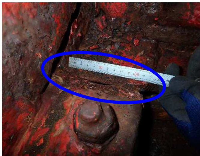
損傷箇所 (主桁フランジ部分)
