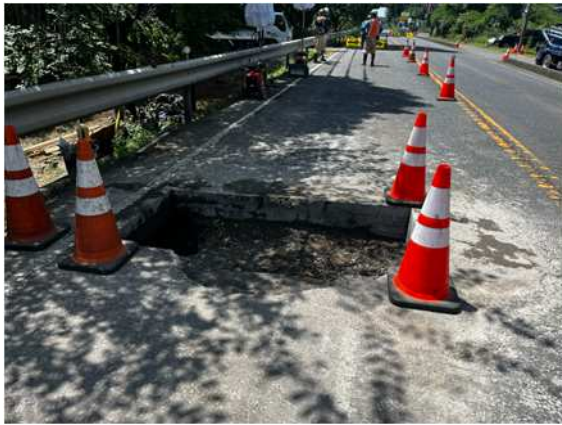
舗装取り壊し
