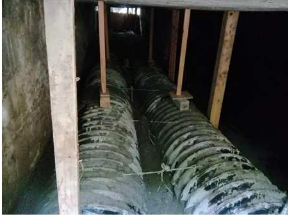
モルタル充填(1回目)
