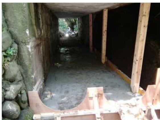
底盤コンクリート打設(上り)
