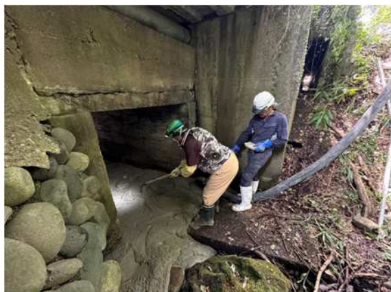
底盤コンクリート打設施工中(下り)
