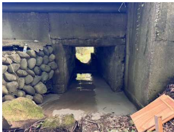
底盤コンクリート打設(下り) 完了
