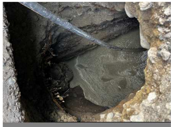
モルタル充填(2回目)
