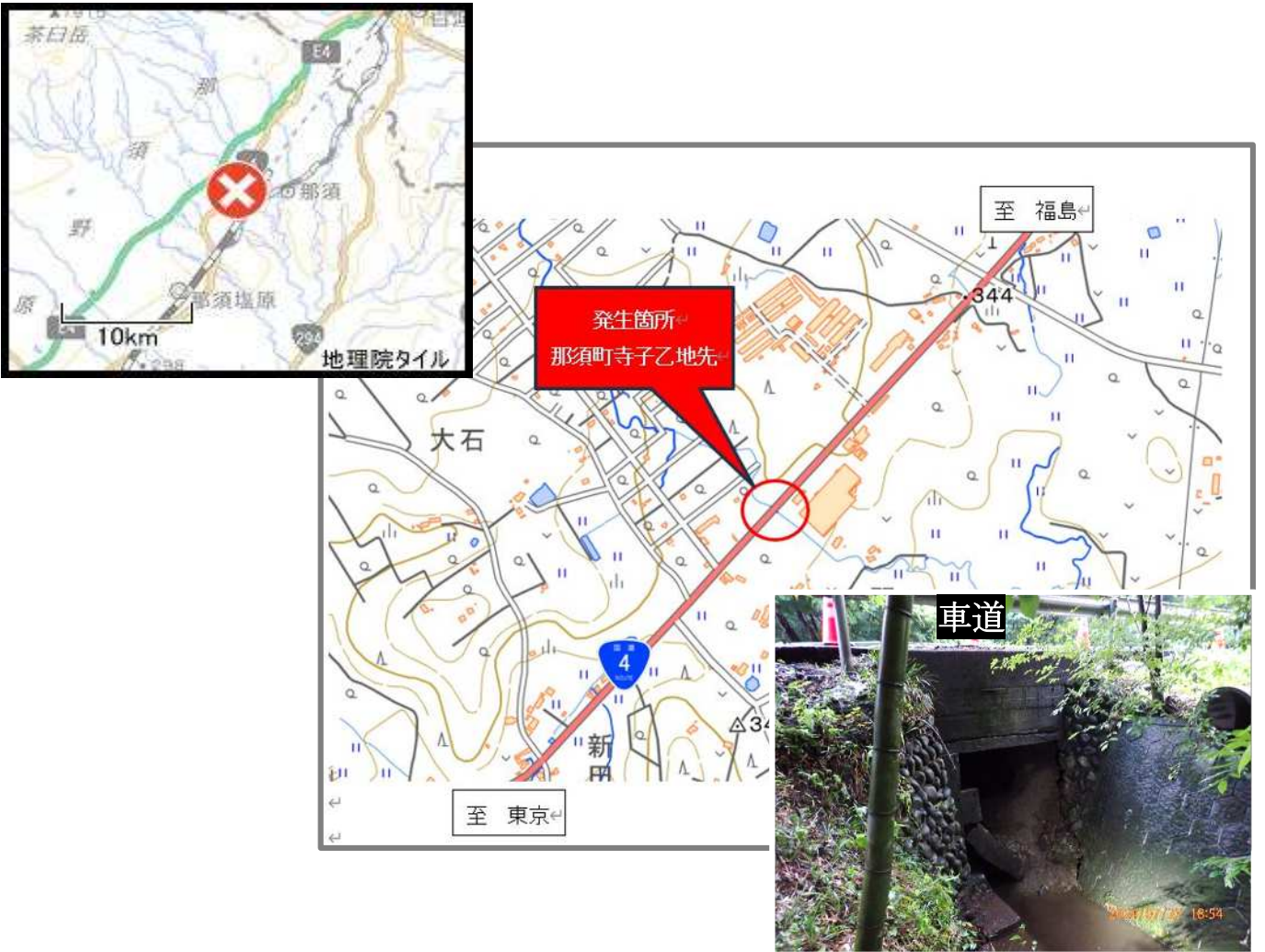
水路ボックスの状況
