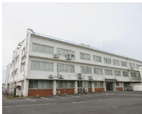
庁舎外観（南面外壁）
