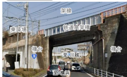
鉄道交差部の状況
