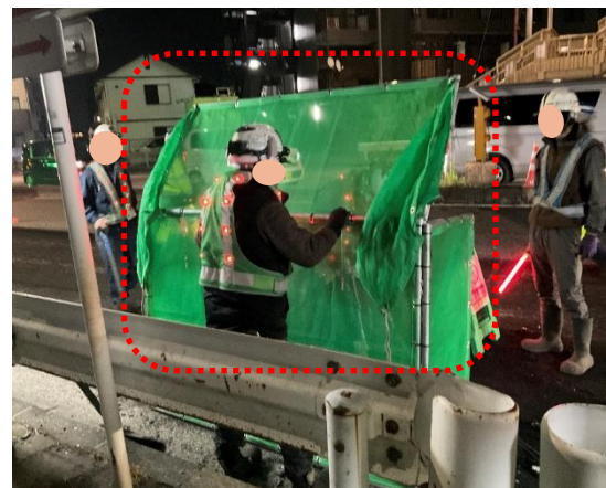
はつり殻が飛散しないよう、ネットフェンスにて養生
