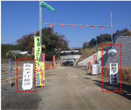
ダンプアップの防止のため出入口にカーブミラーを設置
