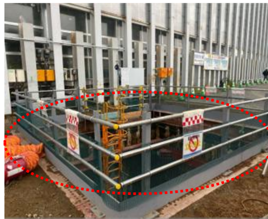
開口部をトリカルネット(目の細かいネット)で養生
