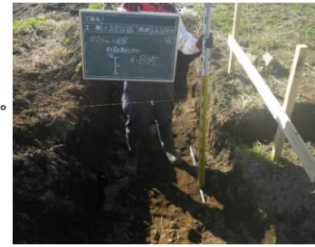
【試掘による確認】
