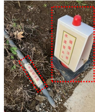
埋設位置の明示、注意喚起標識の設置
