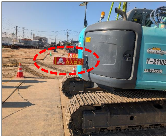
接触防止バーを設置
