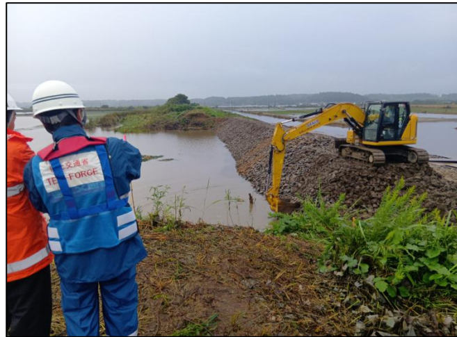
荒締切工施工中
