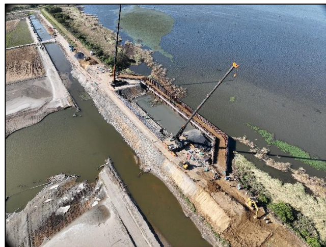
二重締切工(中詰め)施工中
