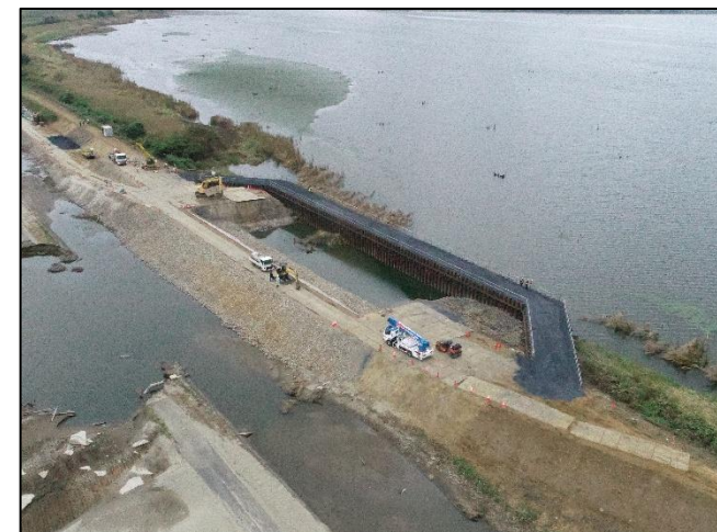
二重締切工完了
