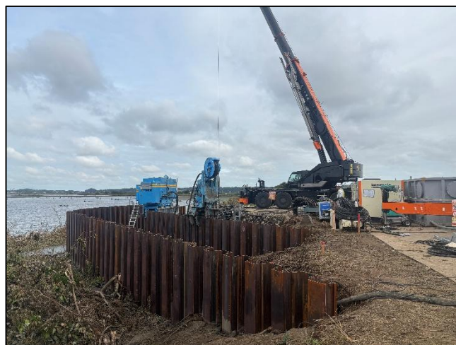
二重締切工(鋼矢板打込み)施工中
