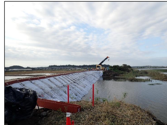
荒締切工完了
