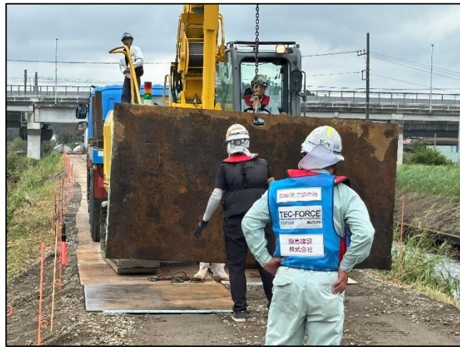
工事用道路施工中
