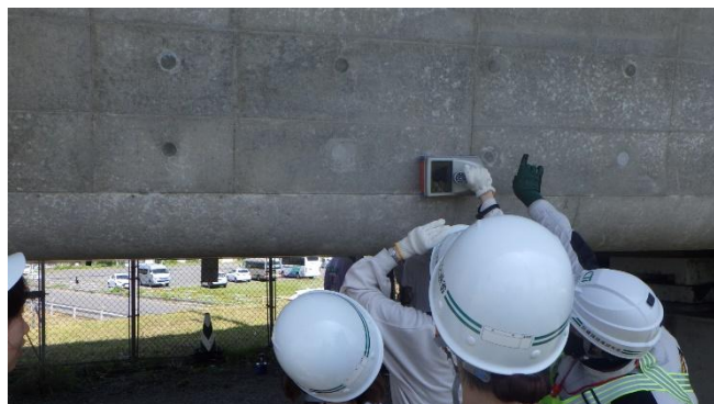
電磁波レーダーによる 鉄筋探査
