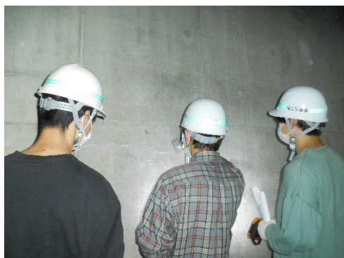
ひび割れ調査
