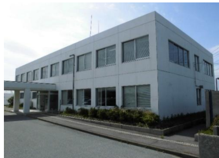
庁舎南側外観
