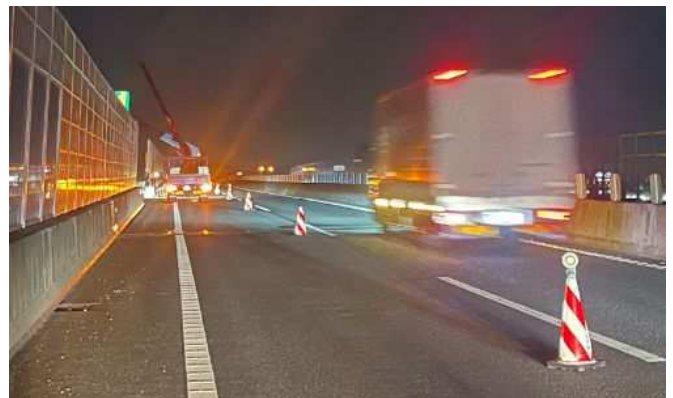
【写真】 車線規制状況
